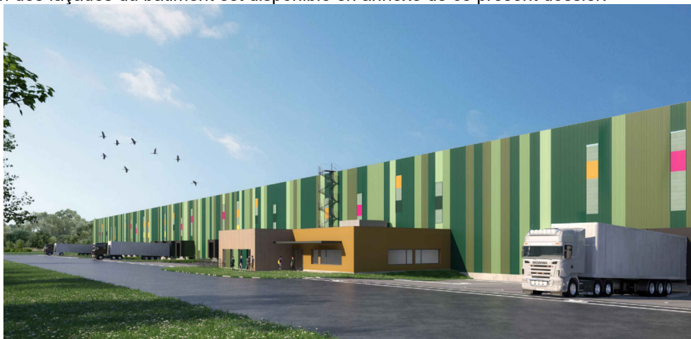
Vue sur façade Nord entrepôt et bâtiment Bureaux/Accueil chauffeurs
